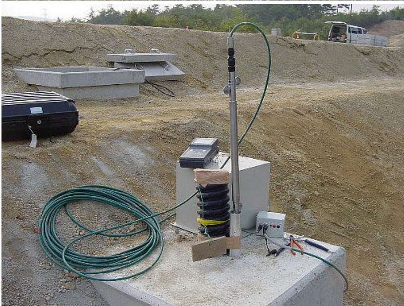
挿入式傾斜計 測定状況
